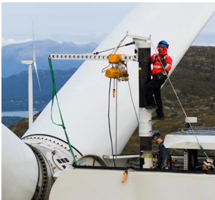
Foto 02: LT1092 montado no topo do aerogerador.
